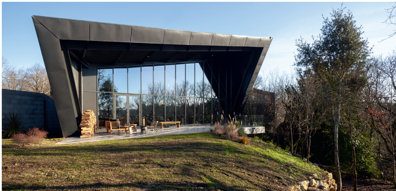
Le mur rideau SL50 se hisse jusqu'à 7 m avec seulement deux appuis. © Photo : Pauline Turmel.
